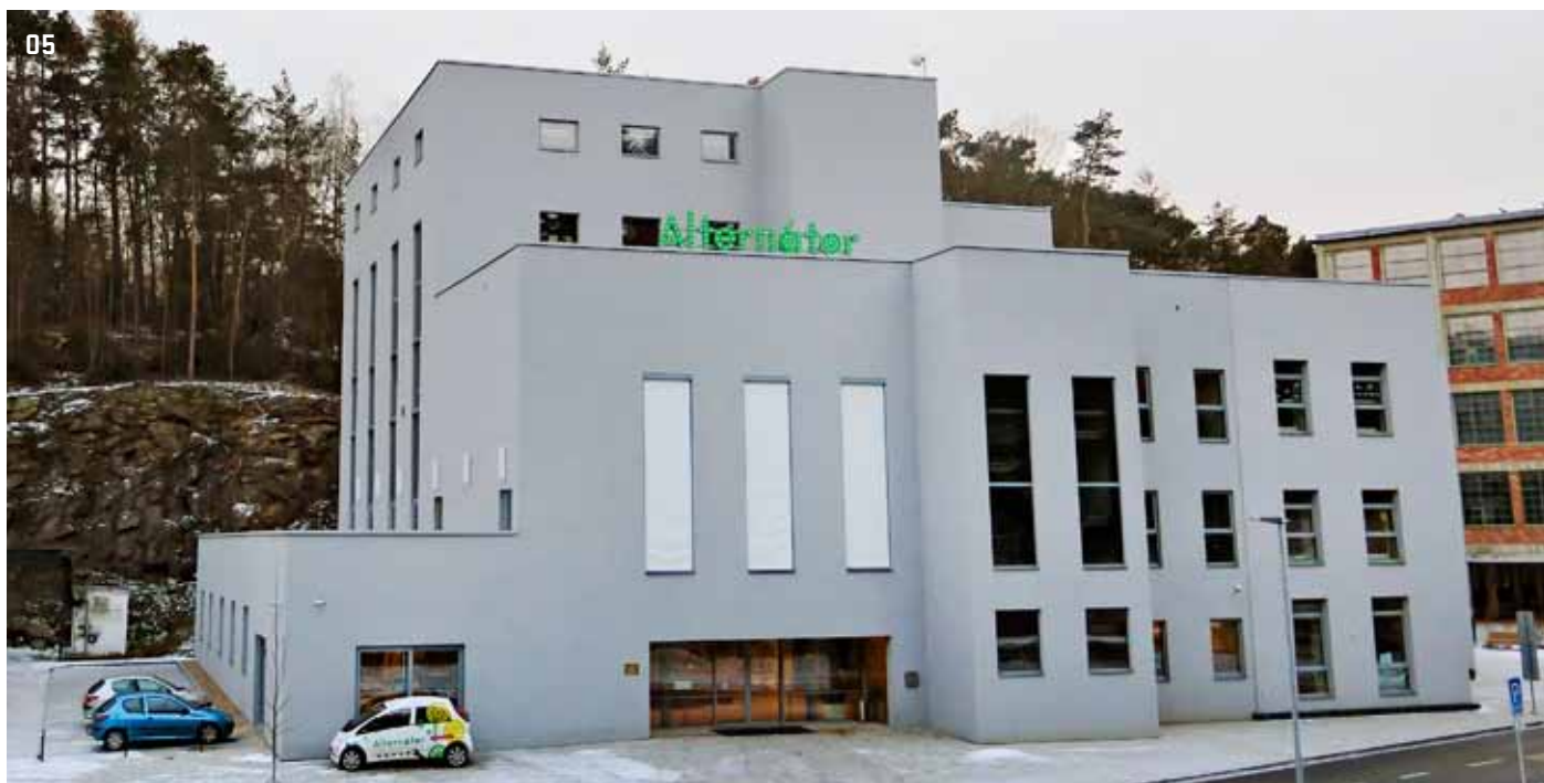
05 > Budova Alternátoru a domu dětí a mládeže je chloubou současné Boroviny. Vznikla přitom z bývalé kotelny, která se měla původně zbourat.
