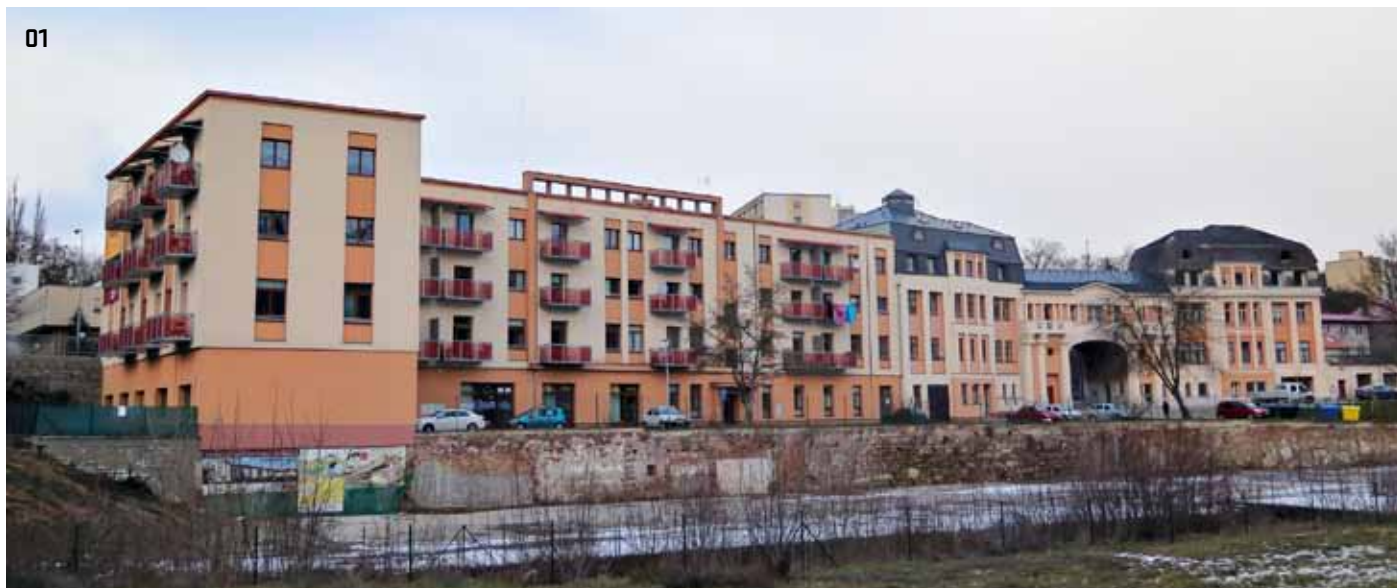
01 > Nynější podoba „Hradu“ a „Brány“. Současná moderní bytová výstavba v „Hradu“ vlastně navazuje na 40. léta 20. století – tehdy zde bydlelo několik rodin, než se přestěhovaly do Baťových domků.
